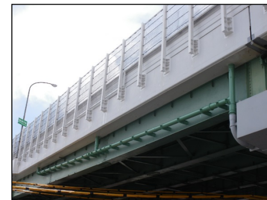
取替え完了(全景)
