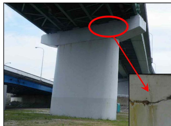
梁側面部の 浮き・ひび割れ
