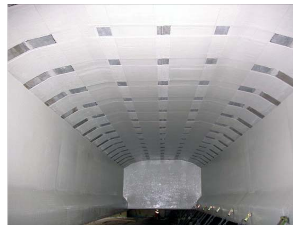
繊維シート補強工(床版下面)
