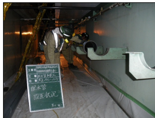
取替え状況(足場内)
