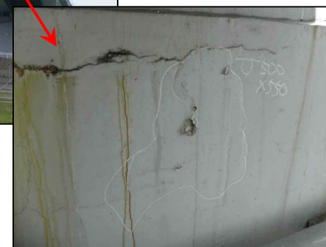
梁側面部の 浮き・ひび割れ
