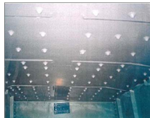
鋼板接着工(床版下面)
