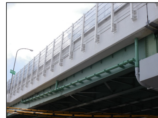
取替え完了(全景)
