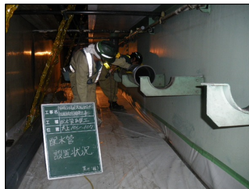
取替え状況(足場内)
