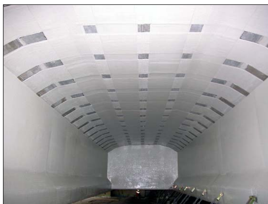
繊維シート補強工(床版下面)
