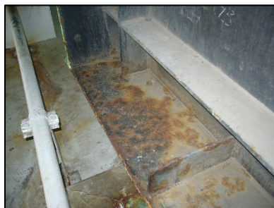
鋼桁の損傷(漏水による錆)
