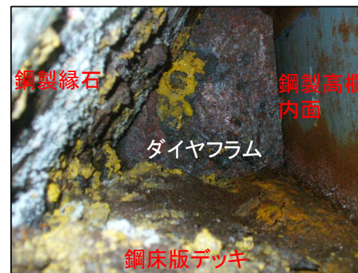
鋼製高欄地覆内部損傷
