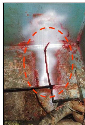
支承ソールプレート溶接部
