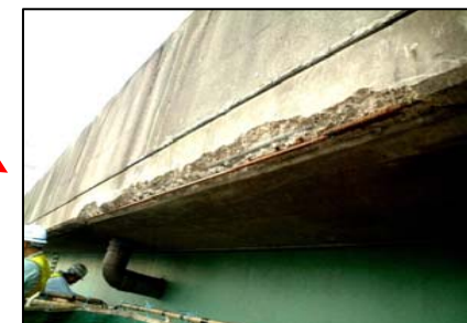
コンクリート高欄の損傷(欠け落ち)
