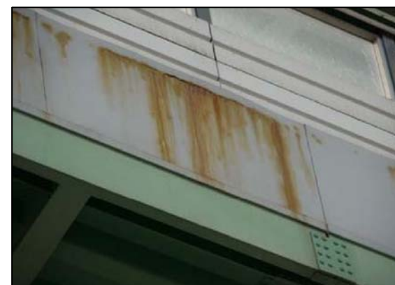
鋼製型枠の錆・き裂
