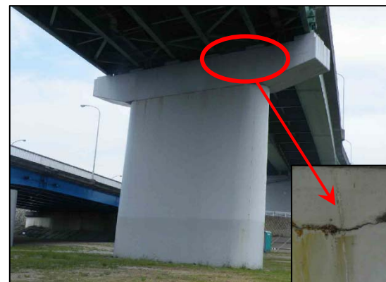
梁側面部の 浮き・ひび割れ
