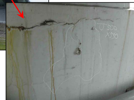
梁側面部の 浮き・ひび割れ
