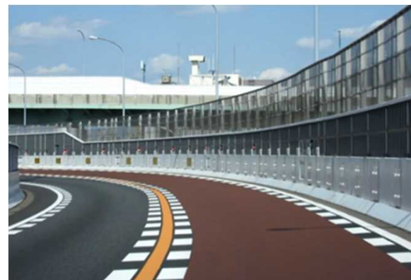
カーブ区間などの事故多発区間を中心に、 カラー舗装を始めとする交通安全対策を実施 （東片端JCT 北カーブの例）
