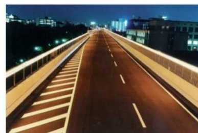
<パイプ照明 (中区丸の内付近) >
