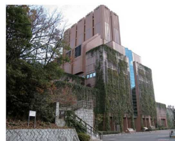
<緑橋換気所(壁面緑化)>
