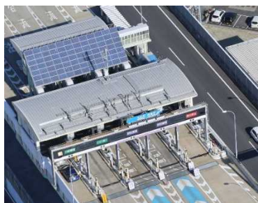
< 太陽光発電（大山川料金所） >
