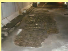
コンクリート床版の 損傷
