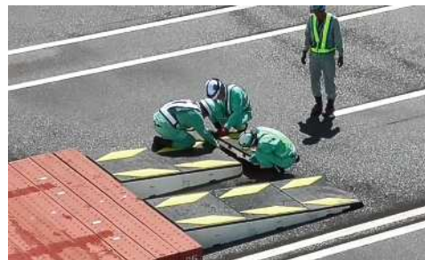
段差の応急復旧訓練
