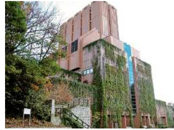
緑橋換気所(壁面緑化)
