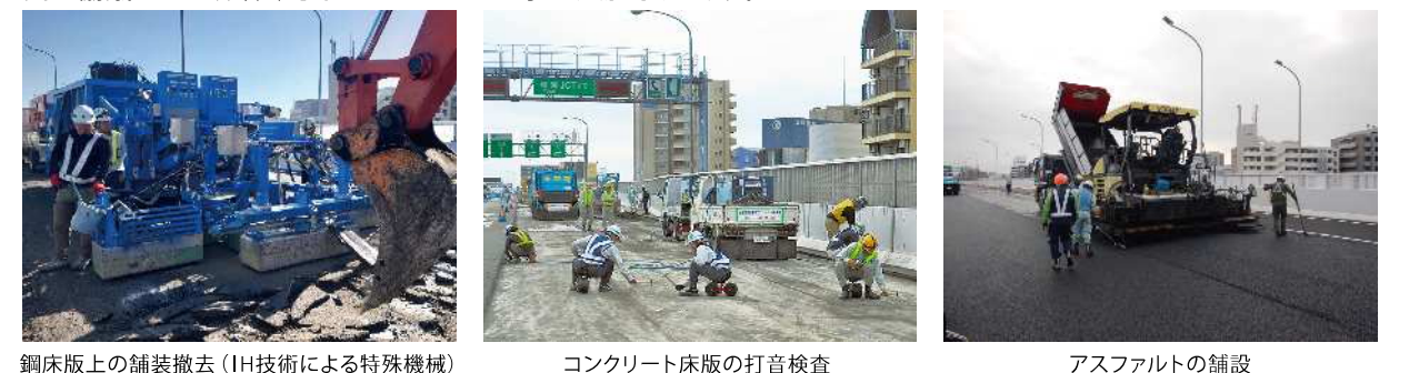
鋼床版上の舗装撤去（IH技術による特殊機械）
