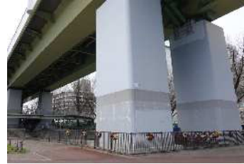
2号東山線久屋大通付近丸みを帯びた梁なし2柱式橋脚の採用
