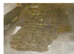
コンクリートの損傷・鉄筋腐食
