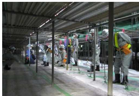
安全管理アドバイザーによる現場視察
