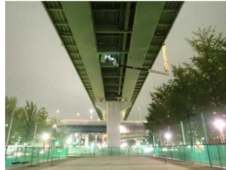
橋梁点検車を使った点検
