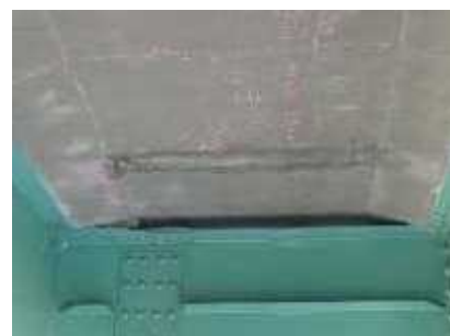
コンクリート床版の損傷状況
