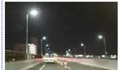
LED照明(本線上)
