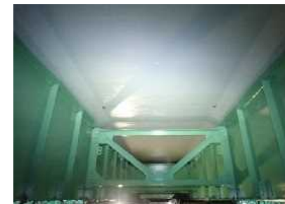
繊維シート貼付による補強
