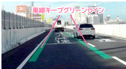
車線キープグリーンライン対策(鶴舞南JCT合流部)
