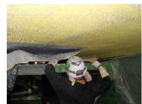
繊維シートの設置
