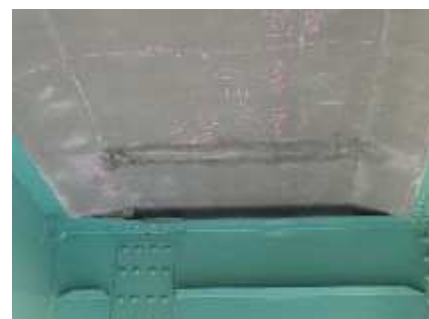
コンクリート床版の損傷状況
