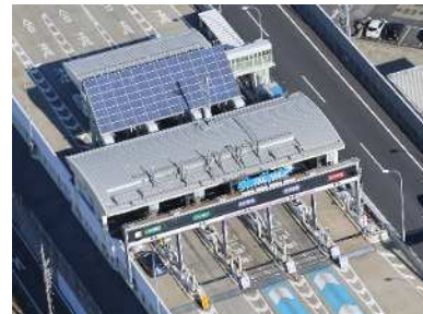
太陽光発電 (大山川料金所)
