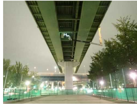
橋梁点検車を使った点検
