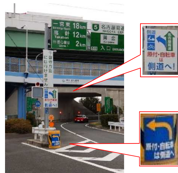
黄金入口における看板設置【誤進入安全対策】
