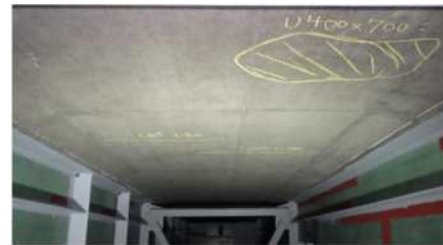
コンクリート床版下面
