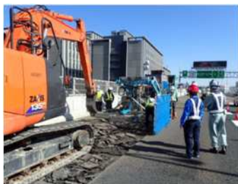
舗装撤去の状況
