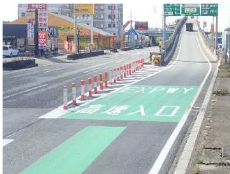
小牧北入口における路面標示【誤進入安全対策】
