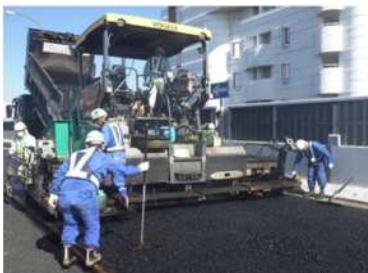
アスファルト舗設の状況
