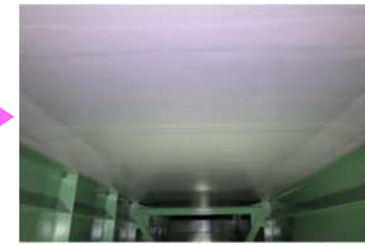
繊維シートによる補強
