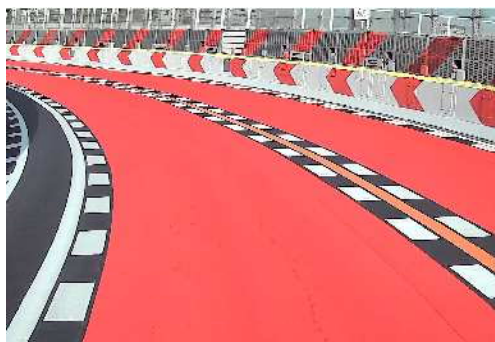
鶴舞南JCT南カーブにおけるカラー舗装【事故対策】
