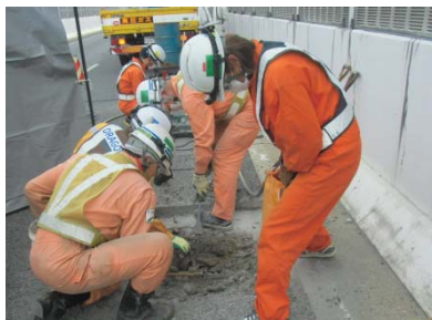
路面の緊急補修
