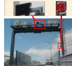
逆走検知・警告システム (吹上東出口)
