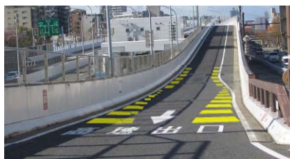
施工イメージ (黄色カラー舗装)
