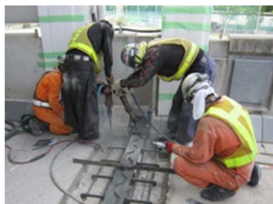
ジョイントの補修
