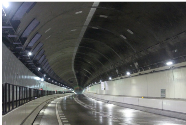
LED化が完了した東山トンネルの様子
