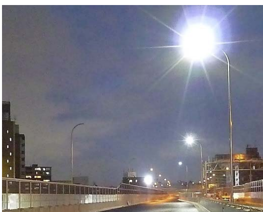
LED照明（4号東海線六番北入口付近）
