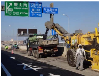
既設舗装の切削撤去
