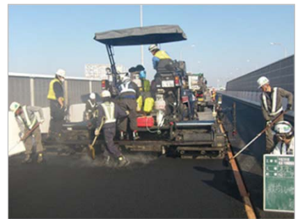
高機能舗装の舗設
