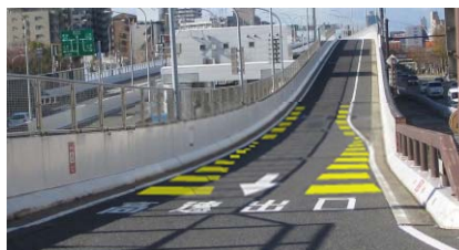
施工イメージ (黄色カラー舗装)
