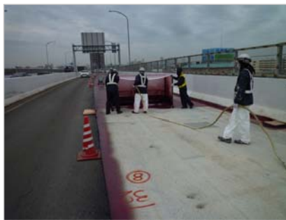
床版防水層の設置
