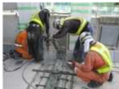
ジョイントの補修
