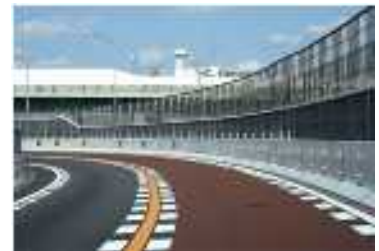
東片端JCT 北カーブにおける交通安全対策の例【事故多発区間】
