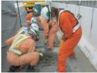
路面の緊急補修
