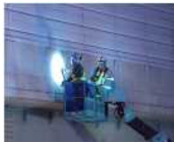
近接目視点検
