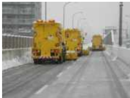
除雪状況と凍結防止剤散布状況
