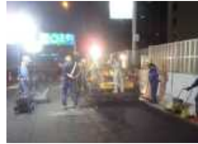
舗装工事実施状況
