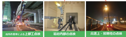
図・写真-1 点検実施状況
