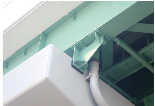
写真9-1-4 変位制限装置
