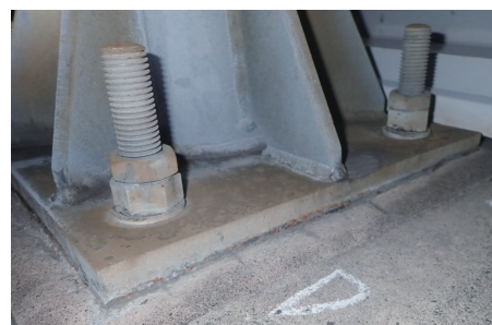
写真 上ナットに3種ナットを用いた誤り
