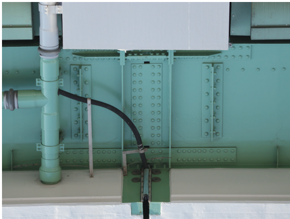
写真9-1-3 桁の連続化
