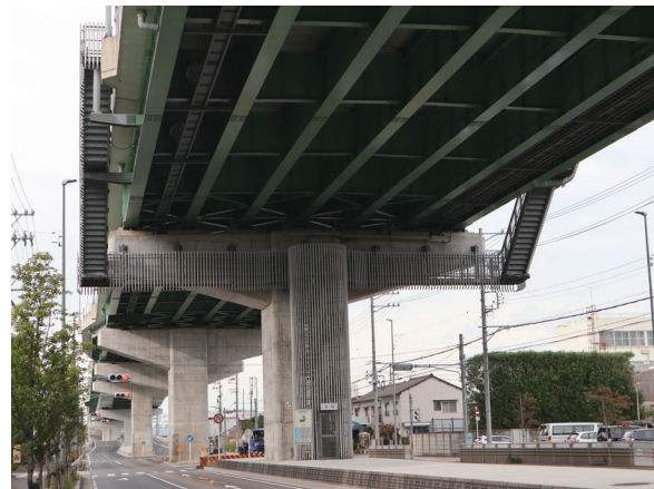
写真9-1-2 高架下の非常階段出口
