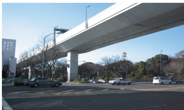
写真6-5-1 都心環状線（明道町JCT～東片端JCT）
