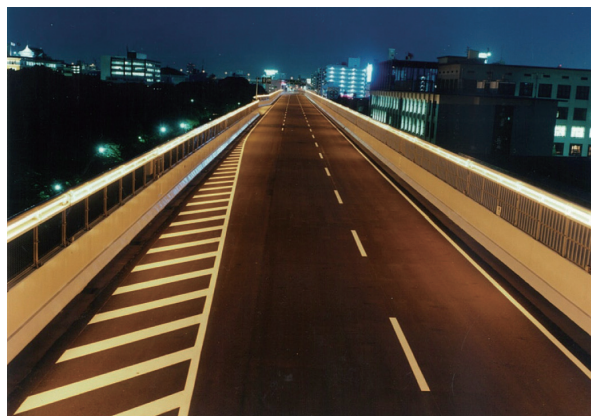
写真6-5-10 パイプ照明（都心環状線）
