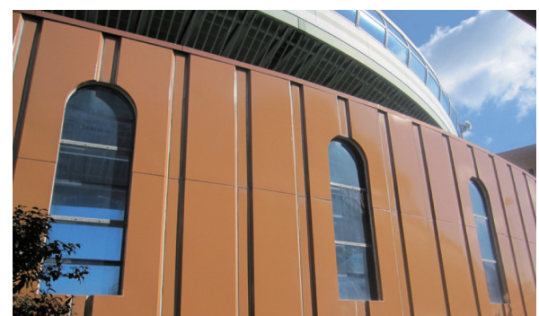
写真6-5-7 同出入口西ループの5m遮音壁
