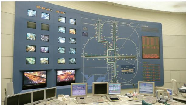
写真4-5-1 第3次システム（モザイク型グラフィックパネル）
