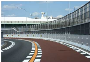
安全対策工事
