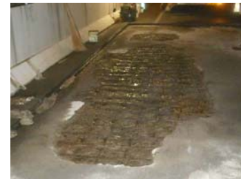
床版上面コンクリートの損傷 ・鉄筋の腐食
