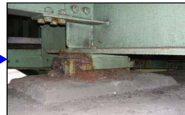
伸縮装置からの漏水により 桁端部・下部工に損傷
